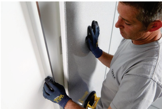
⑬ MISE EN PLACE DU PROFIL LATERAL FINITION
