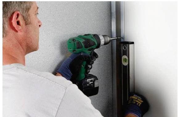
⑭ FIXATION PROFIL ANGLE PAROI COLONNE
