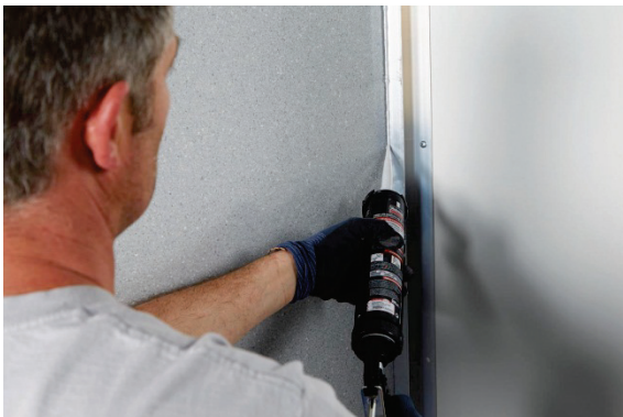
⑮ ETANCHEITE VERTICALE JONCTION PAROI COLONNE
