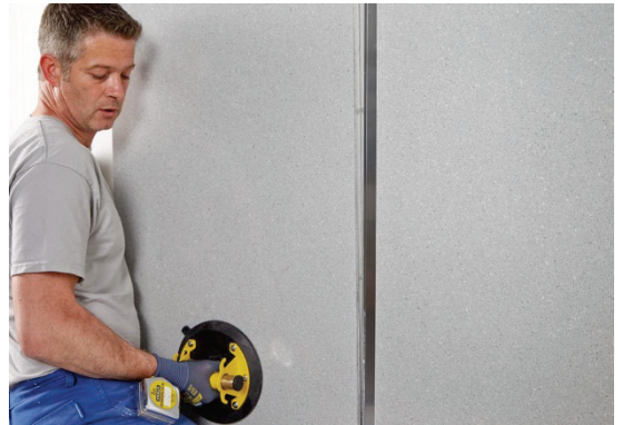
⑫ MISE EN PLACE SECONDE PAROI
