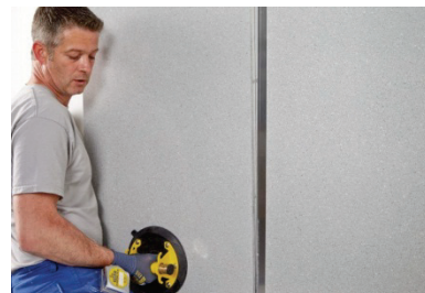
MISE EN PLACE SECONDE PAROI
