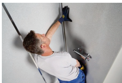
MISE EN PLACE PAROI COLONNE
