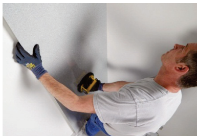
MISE EN PLACE PREMIERE PAROI
