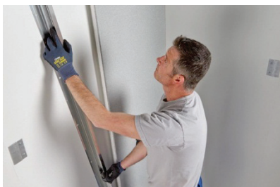
MISE EN PLACE PROFIL INTERMEDIAIRE
